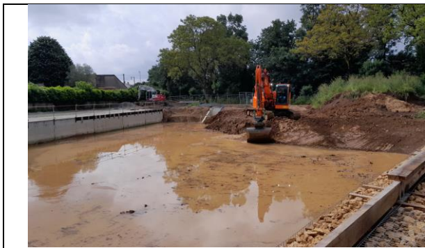
Figure 5a : terrassements bassin Espace Lambon (Niort)
