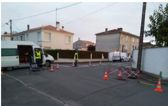
Contrôle avec étalonnage d'un point autosurveillance réseau (DO Jean Macé à Niort)
