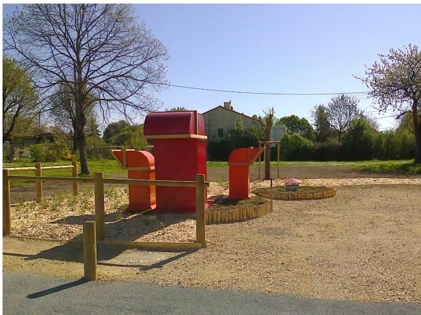
Figure 2 : poste Refoulement Amuré
