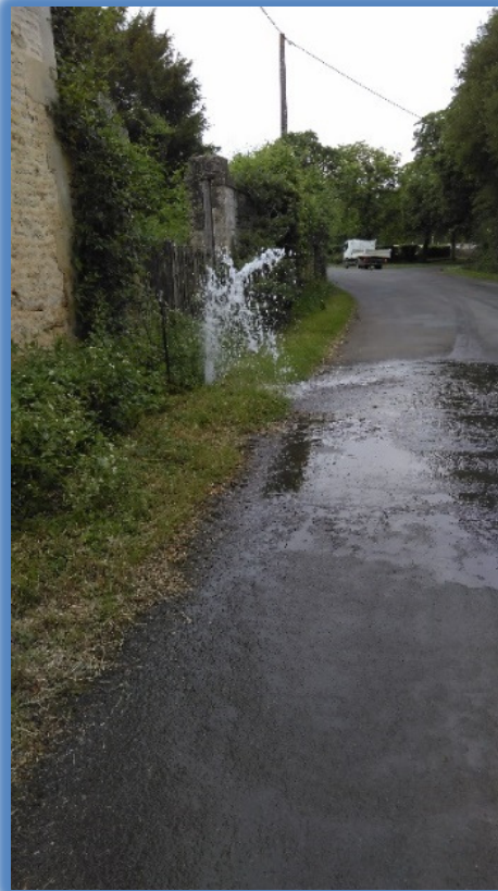
Réalisation d'une purge sur le réseau
